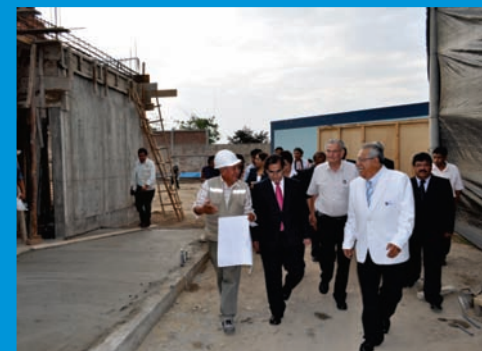
Haciendo una inspección al búnker del IREN Norte que albergará los servicios de: radioterapia, imagenología y laboratorio
