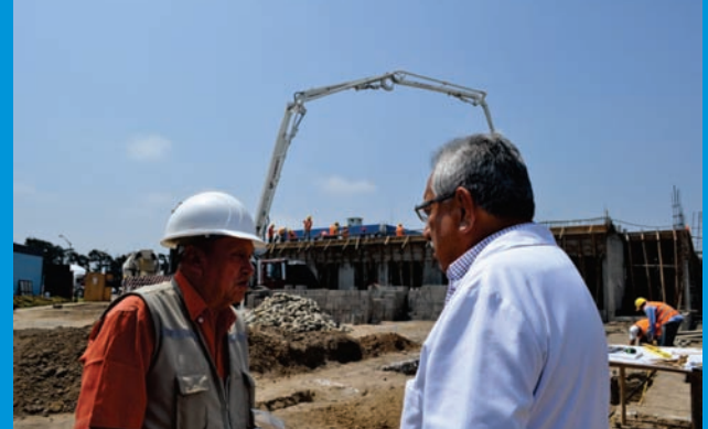
El Director Ejecutivo de IREN Norte, Dr. José Ayala Ravelo, acompañado por la Directora de Administración, Lic. Katherine Torres; Directora de Planeamiento y Presupuesto, Econ. Maritza Castillo; inspeccionando los avances en la construcción del búnker de la institución oncológica
